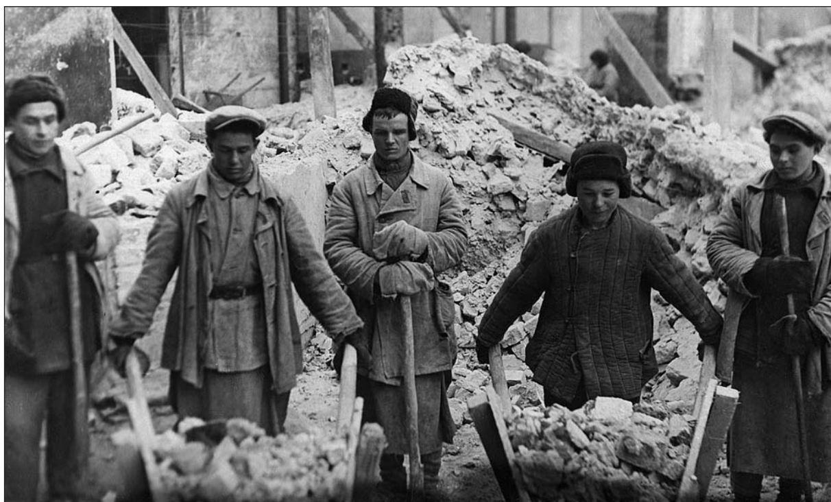
Члены ударной бригады каменщиков на строительстве Казанского химического завод им. Куйбышева. Казань. 1930-е гг. ЦГА ИПД РТ
