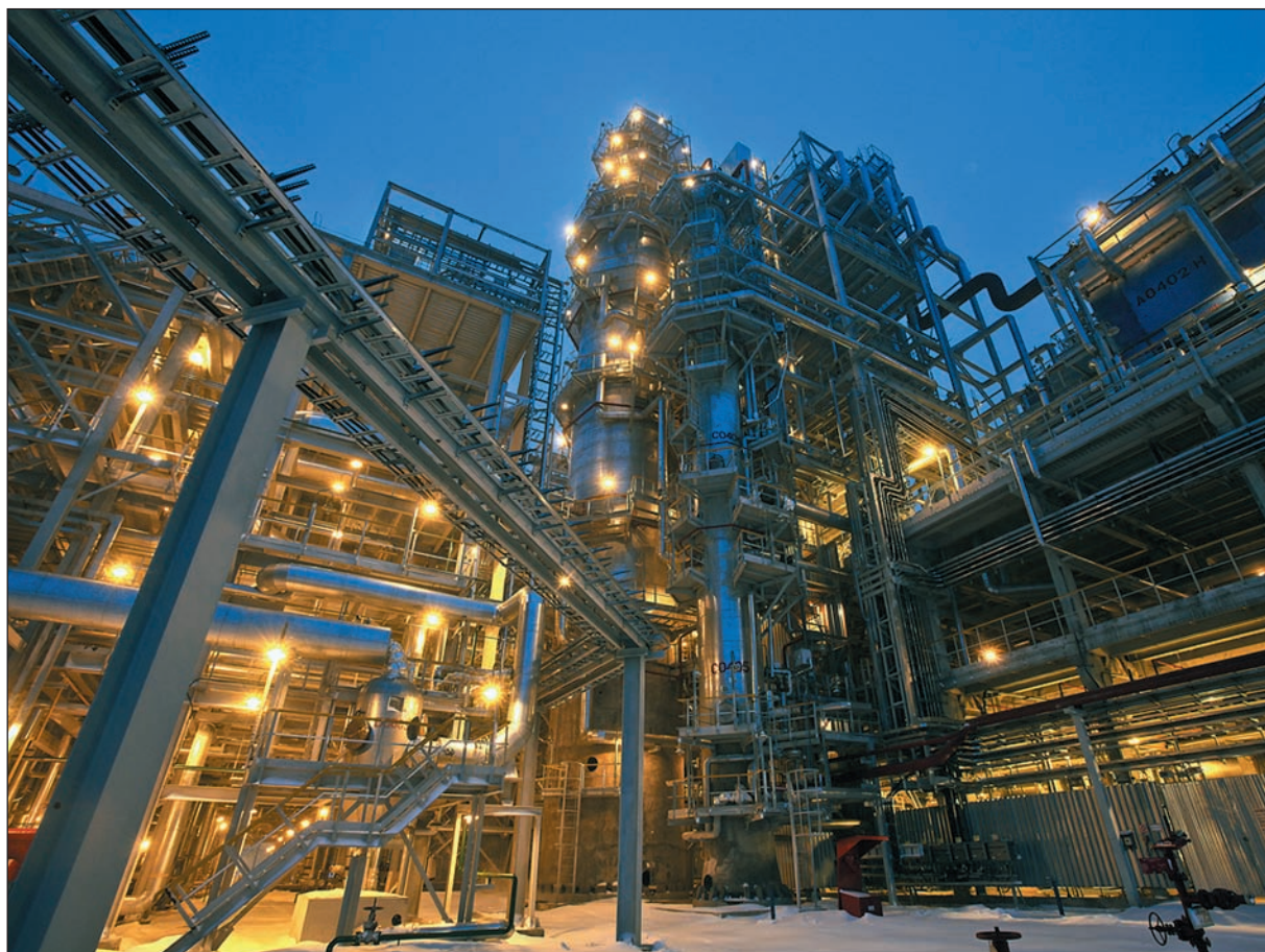
Комплекс нефтеперерабатывающих заводов ОАО «ТАНЕКО». Нижнекамск. 2012 г.
