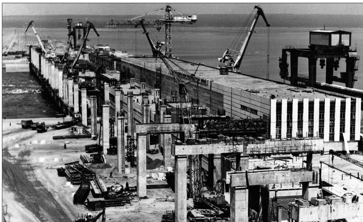
Нижнекамская ГЭС. Нижнекамск. 1980 г. ЦГА ИПД РТ
